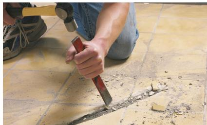
5. Штробление канала и установка гофротрубки для датчика:
